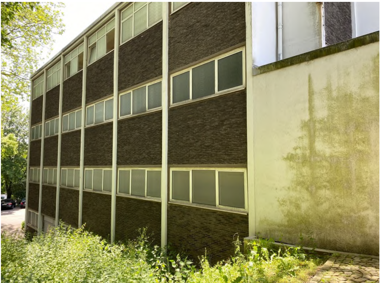
Aktuelle Ansicht Außenfassade Haus 3 - seitlich
