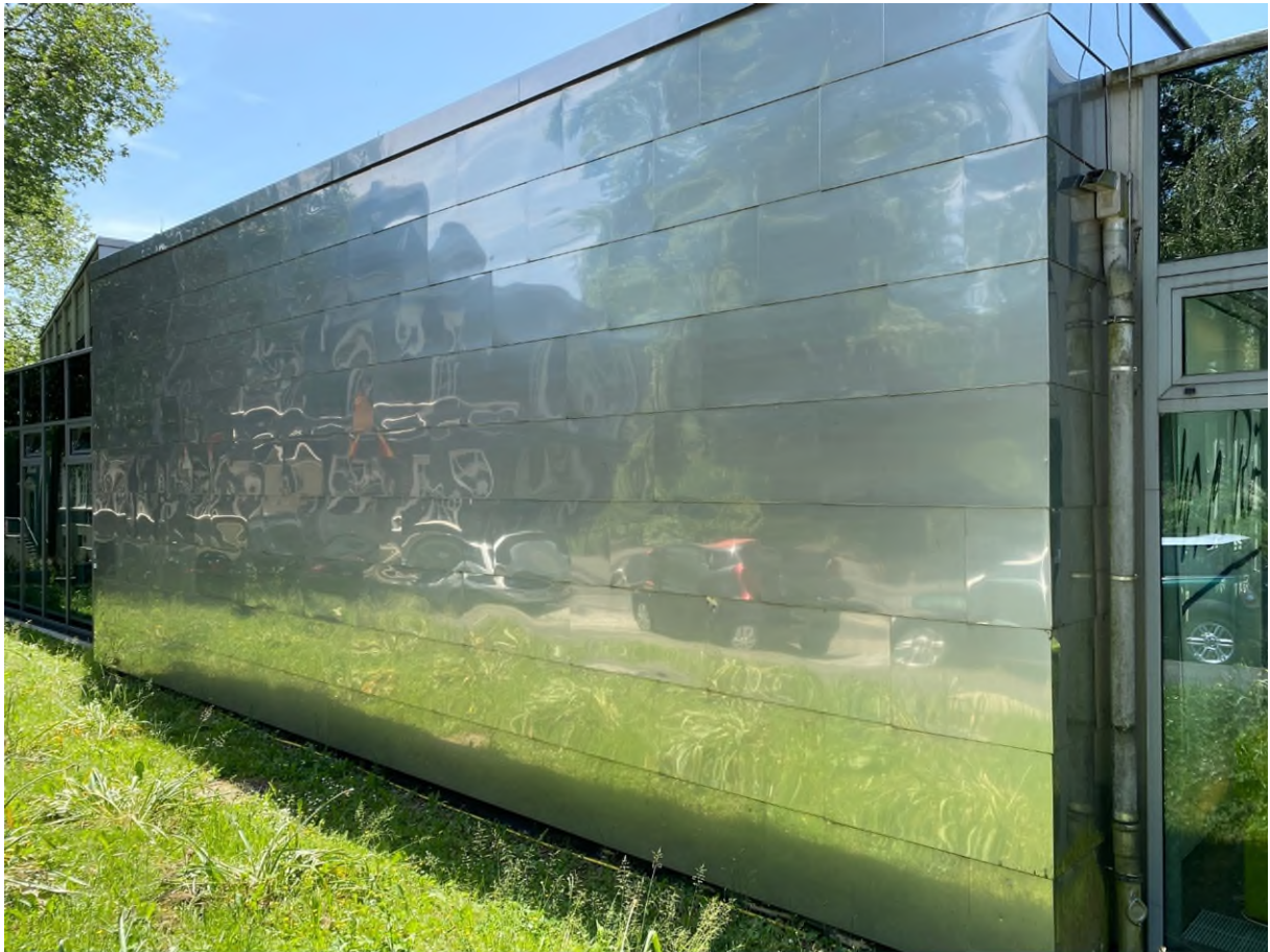
Aktuelle Ansicht Edelstahlfassade
